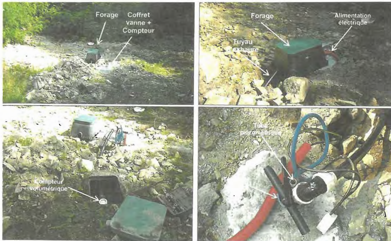
Figures 10 – Vues de la tête de forage et de la fosse technique du compteur volumétrique après la réalisation des travaux et avant la mise en place de la margelle de protection
